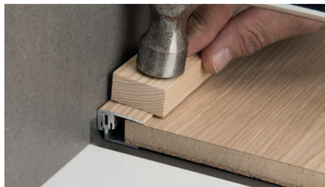
Instalace ukončovacího profilu hliníkového
